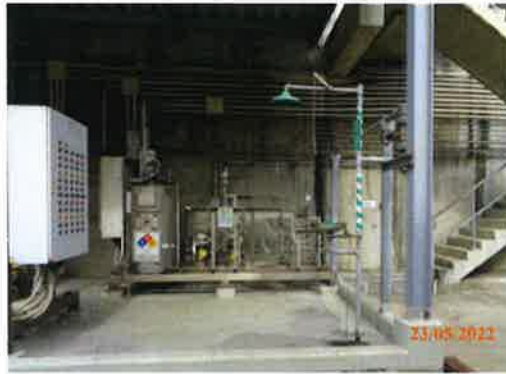
รูปที่ 54 อ่างล้างตาฉุกเฉิน และฝักบัวชำระล้างร่างกาย
