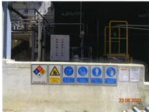
รูปที่ 55 กำแพงคอนกรีตล้อมรอบถังน้ำมันและสารเคมี
