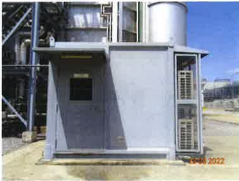
รูปที่ 1 ระบบตรวจสอบคุณภาพอากาศ แบบต่อเนื่อง (CEMs)
