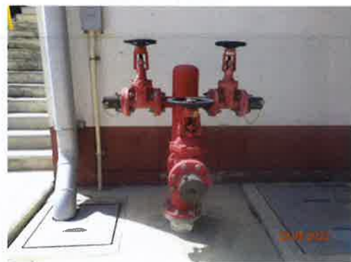
รูปที่ 48 Fire Hydrant
