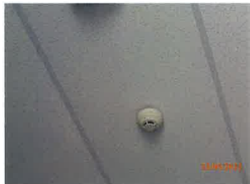
รูปที่ 32 Smoke Detectors
