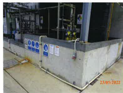
รูปที่ 55 กำแพงคอนกรีตล้อมรอบถังน้ำมันและสารเคมี
